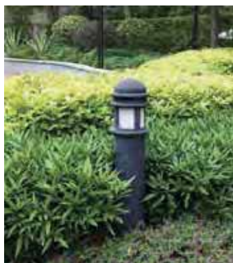
Wegeleuchten mit integrierter kleiner Antenne
