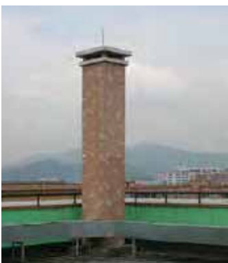
Schornstein zur Tarnung bestehender Antennenstandorte
