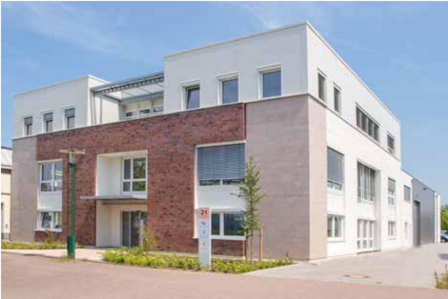
Firmensitz im Stahlwerk Becker in Willich
